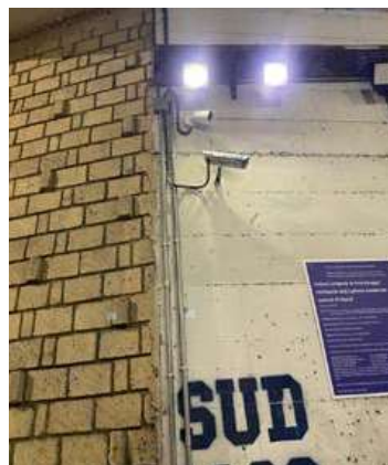
Dispositivi per il monitoraggio intelligente delle gallerie stradali installati nel Comune di Napoli
